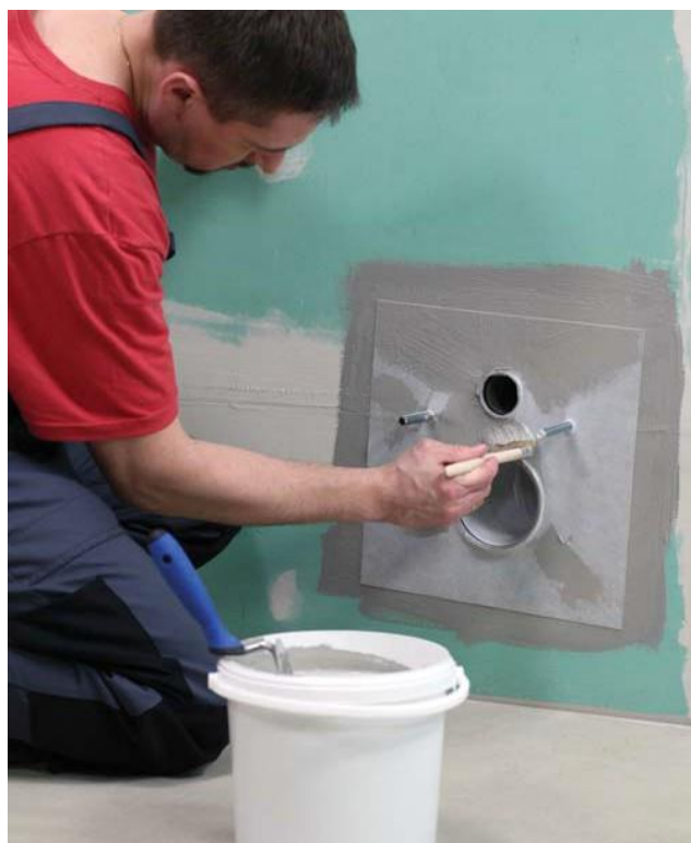
Izolācijas lentes vai tehniskā flizelīna ar maksimālo svaru 60 g/m 2 ielīmēšana.
