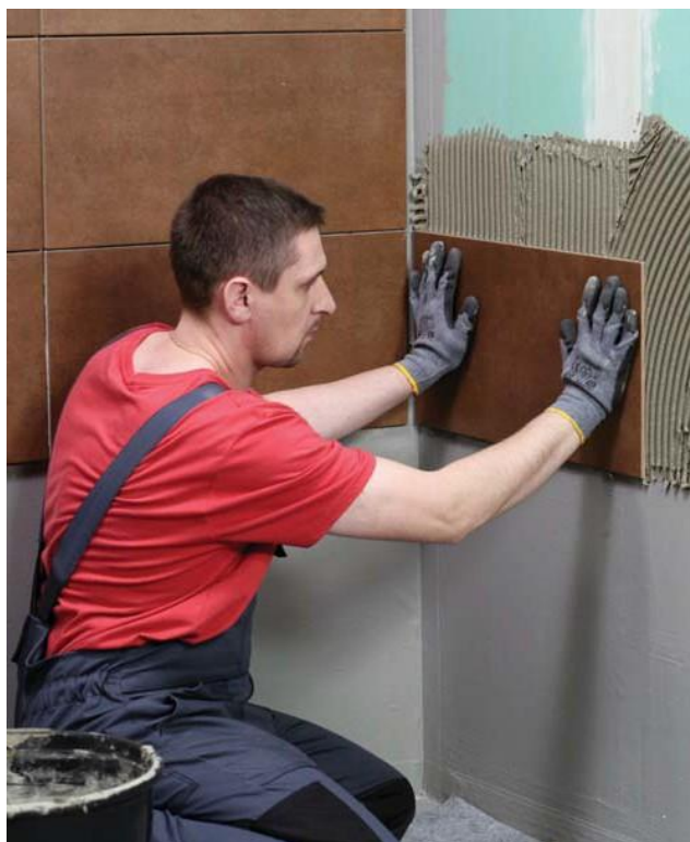
Pēc apmēram 4 stundām var sākt flīžu uzklāšanu.
