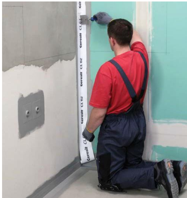
Blīvējošās lentes CL 152 ielīmēšana vertikālā stūrī.
