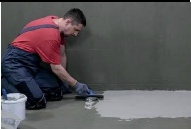
Otrā blīvējošā slāņa uzklāšana, izmantojot roboto rīvdēli.
